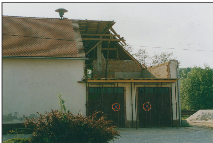
Pričetek del na obnovi doma leta 1996
